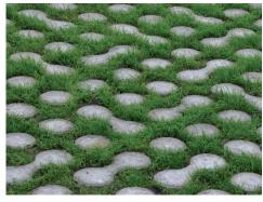
Figura 44: Esempio di pavimentazione drenante
